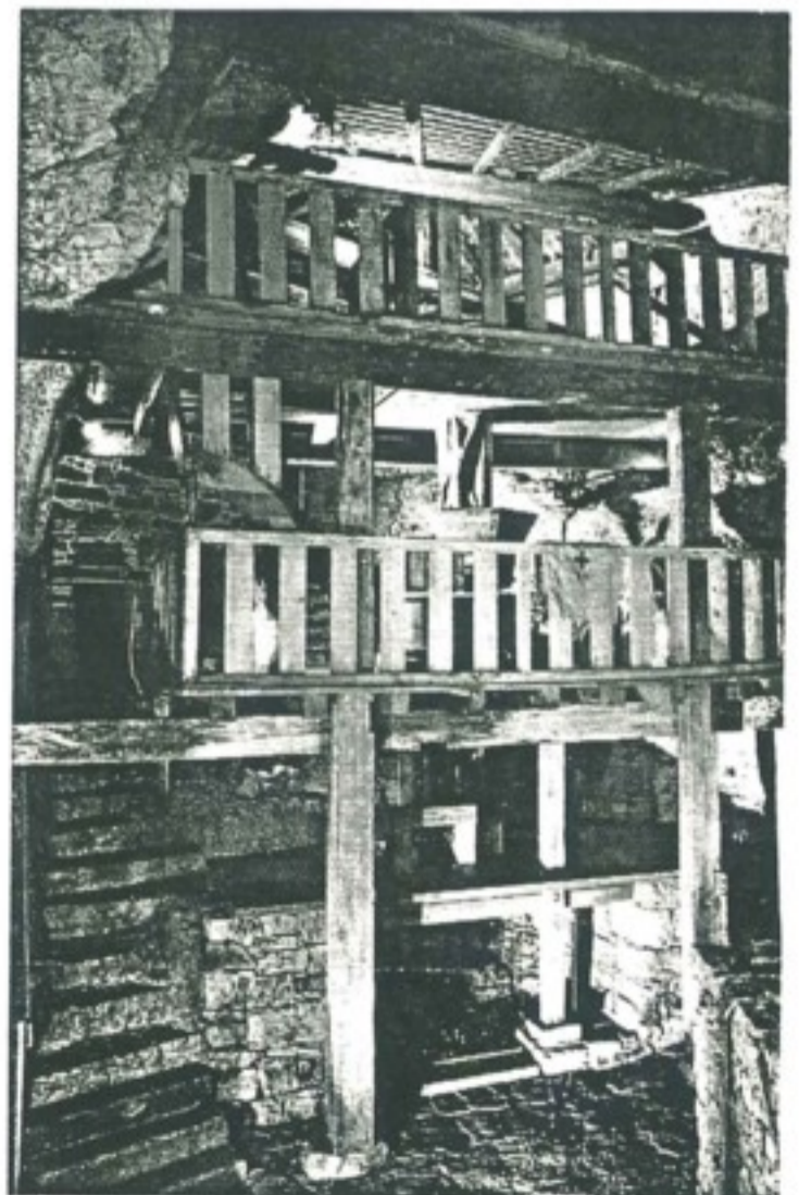
Moulins souterrains du Col-des-Roches
